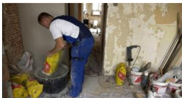
Poolse bouwvakker aan het werk.
